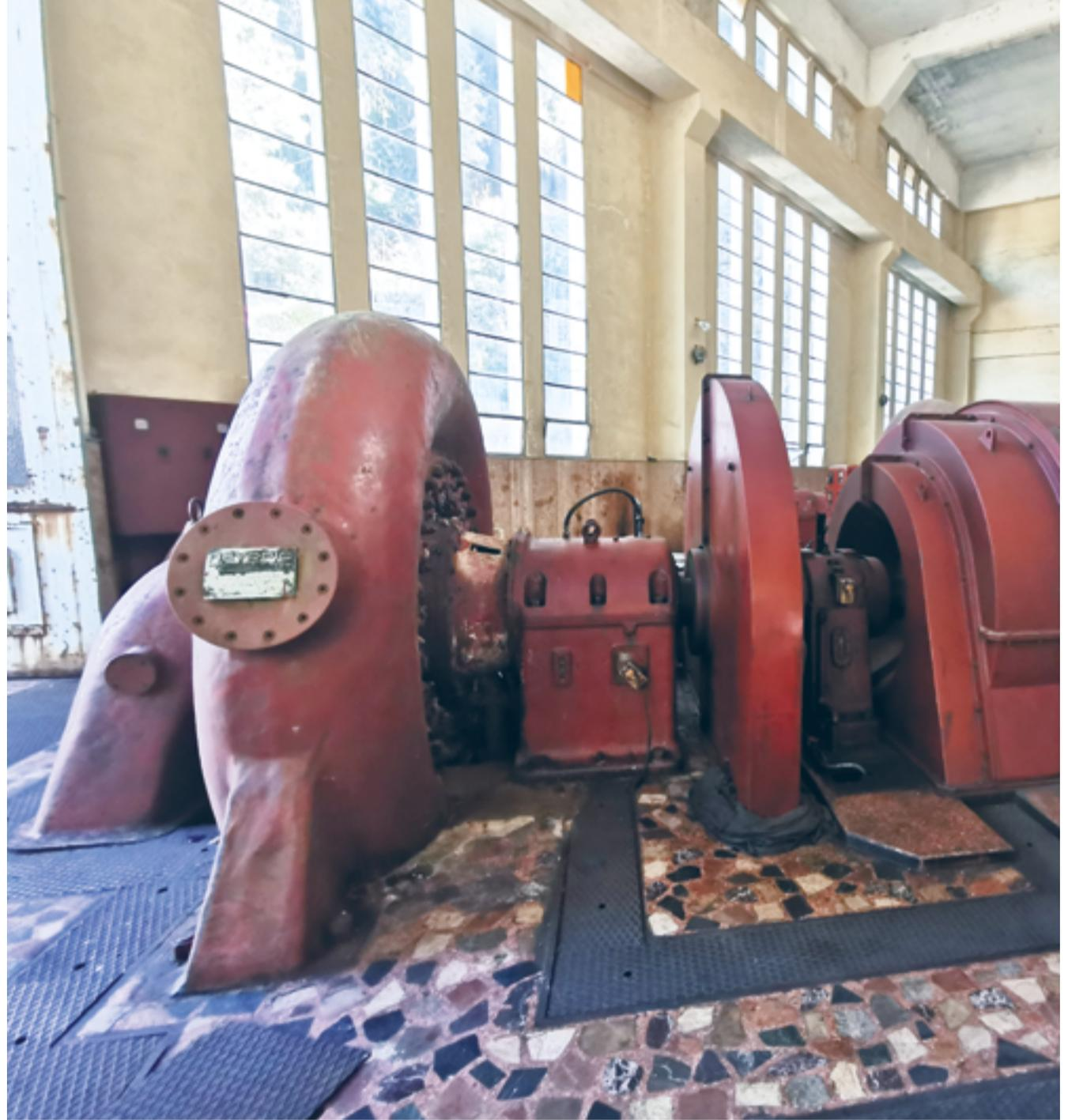
التوربينات داخل معمل نهر إبراهيم حيث يتم توليد الطاقة لكهرمائية
